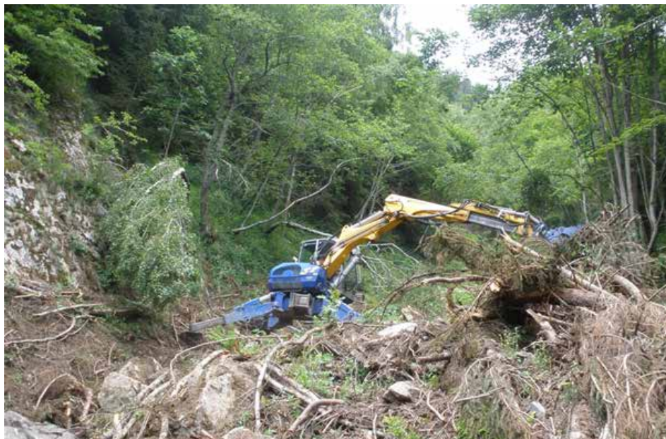
Abb. III.3.3: Wildbachräumung (Foto: WLV Gebietsbauleitung Osttirol)
